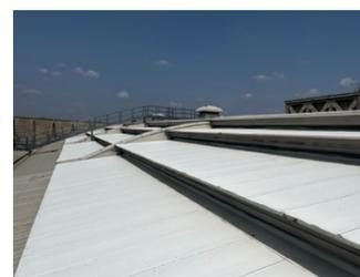
**NEW FAST** ist eine wasserbasierte Elastomer-Acrylbeschichtung, die nach dem Trocknen einen elastischen weißen Film bildet. Schützt Gebäude dank seiner starken Reflexions- und Emissionseigenschaften vor Überhitzung und ermöglicht eine längere Lebensdauer der Dächer. Nach dem Trocknen bleibt der Belag elastisch und haftet gut auf dem Untergrund.
